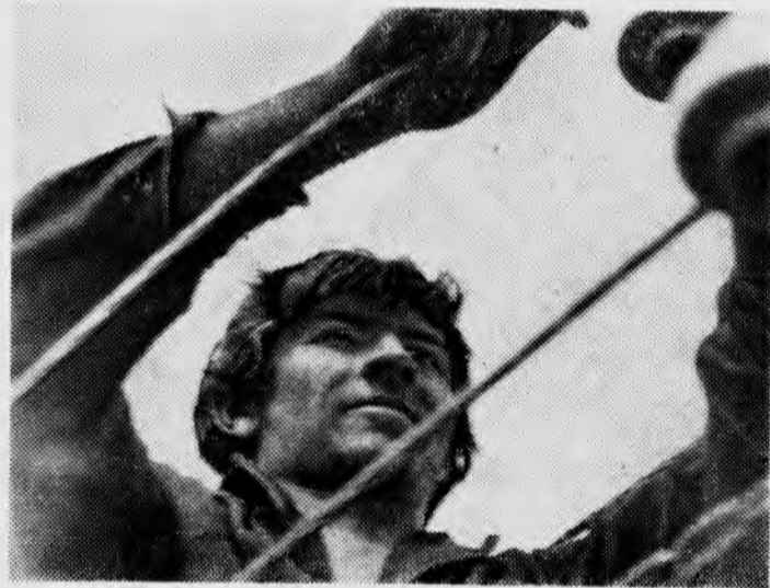
1969 г. М. Бродин на монтаже ЛЭП.
