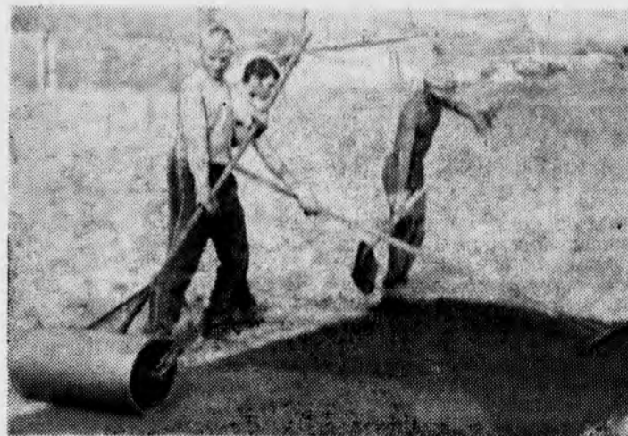
Бойцы отряда «Искатель-69» на строительстве автодороги.
