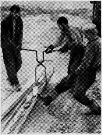
Бойцы «Импюльса-73» В. Гаврилов, Г. Роот и А. Климентьев прокладывали летом дорогу на строительстве завода автоприцепов в Сосновоборне. Фото В. БУЛАТКИНА.
