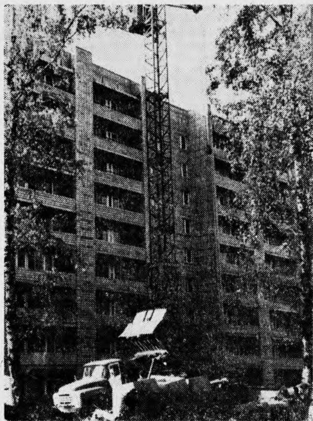
Заканчивается строительство нового жилого дома в Студгородке, в котором получают благоустроенные квартиры современной планировки 40 семей наших преподавателей и сотрудников.
