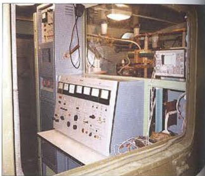
Подвижная электролаборатория ПЭЛ-10 кВ
