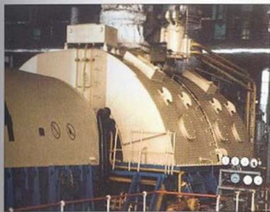
Замена цилиндра низкого давления и генератора на турбине ст. №4 Назаровской ГРЭС (1994)
