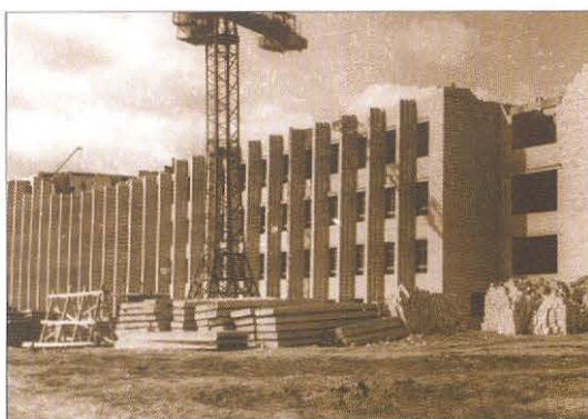
Строится главный корпус
