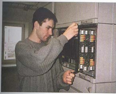
Монтаж станции спутниковой связи
