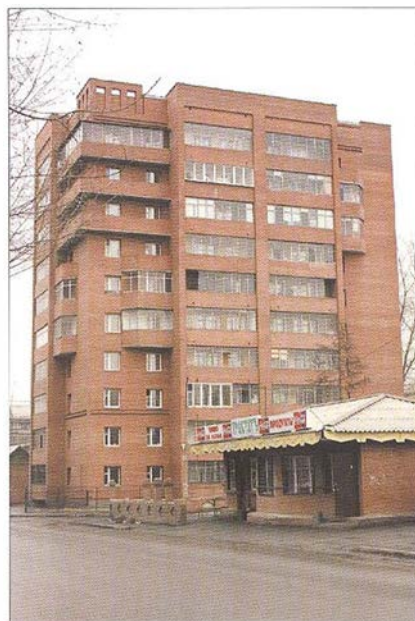
Жилой дом по ул. Мечникова, 35
