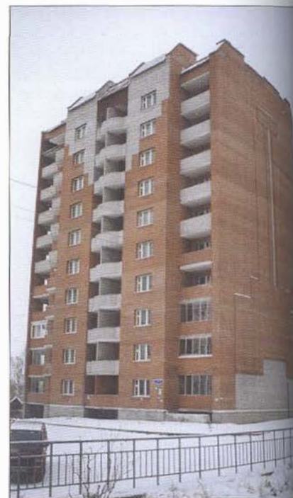
10-этажный кирпичный жилой дом по ул. Сады (ноябрь 2002 г.)
